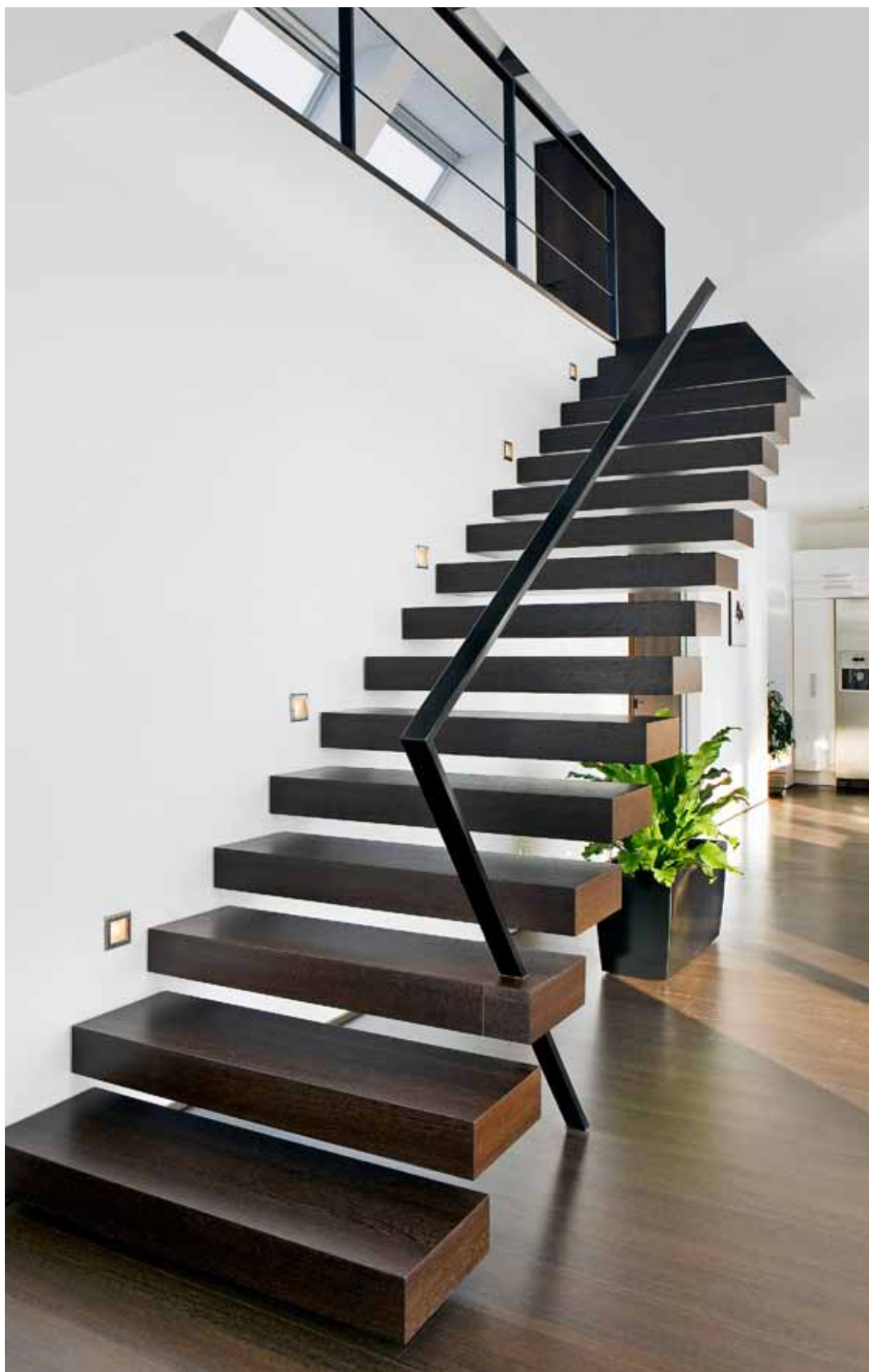
Jednotlivé schodišťové stupně jsou pomocí nosných ocelových prvků konzol kotveny do nosné schodišťové stěny a lemovány jednoduchým ocelovým zábradlím. Zajímavý prostorový efekt zvyrazňuje tmavá dýha wengé
